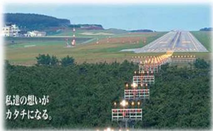
山形県庄内空港整備事業 進入灯設置工事
